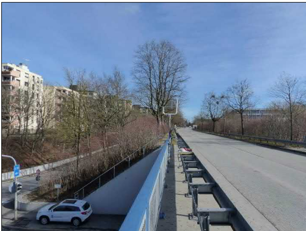
Abbildung 6: Station 1 - Landsberger Straße (Kreuzung), Blick nach Osten
