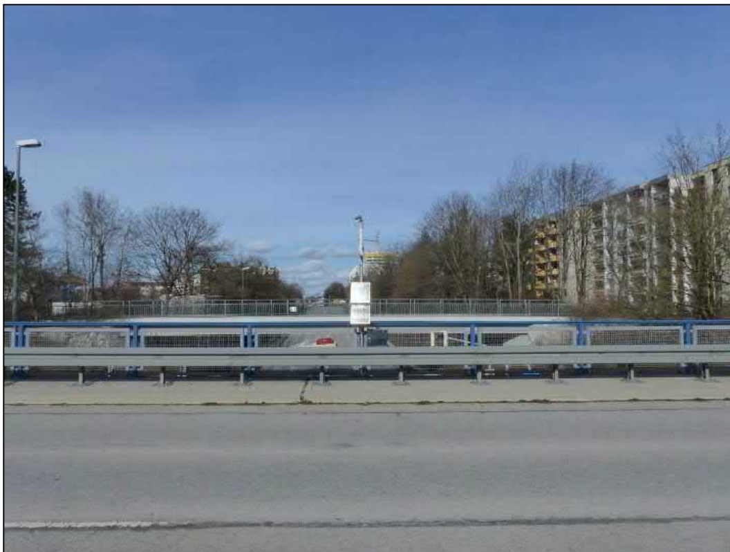
Abbildung 5: Station 1 - Landsberger Straße (Kreuzung), Blick nach Norden
